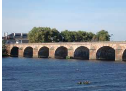
Le Pont Régemortes : Un ouvrage datant du 18ème siècle encore capable de survivre quelques siècles sans frère.
